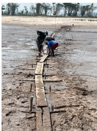
Figura 07: Cenário da seca extrema e construção da ponte de madeira sobre a lama para acesso ao rio. FONTE: ACASFC, 2023.
